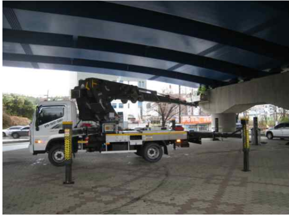
고소작업차를 이용한 근접조사
