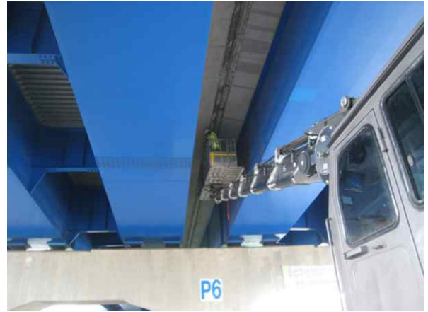
고소작업차를 이용한 근접조사
