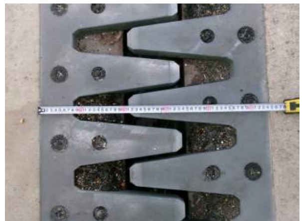
신축이음 이동량 측정
