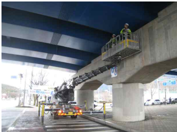
고소작업차를 이용한 근접조사
