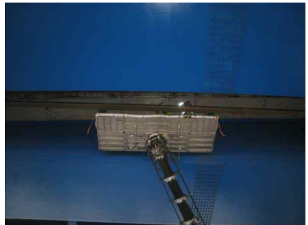
고소작업차를 이용한 근접조사
