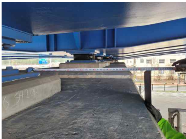
받침장치 연단거리 측정
